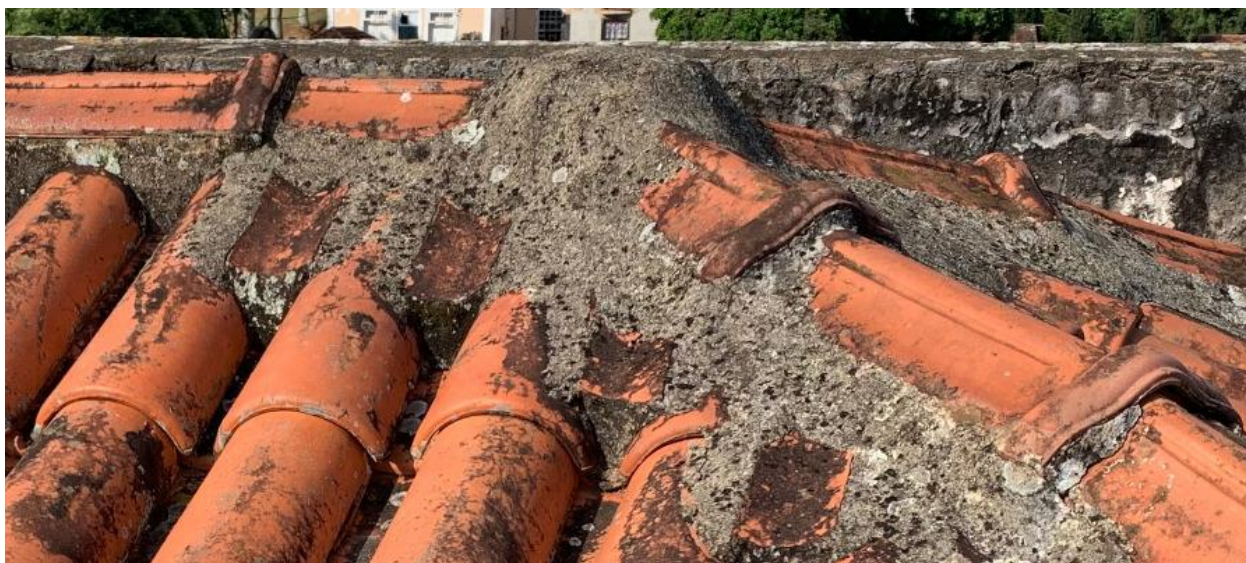
Figura 18 – Água 01, cumeadada da trapeira com bebedouro. Paulo Parrilha Figueiredo Filho, 2021.
