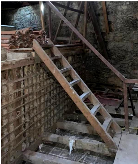
Figura 58 – Escada de acesso ao primeiro desnível.
