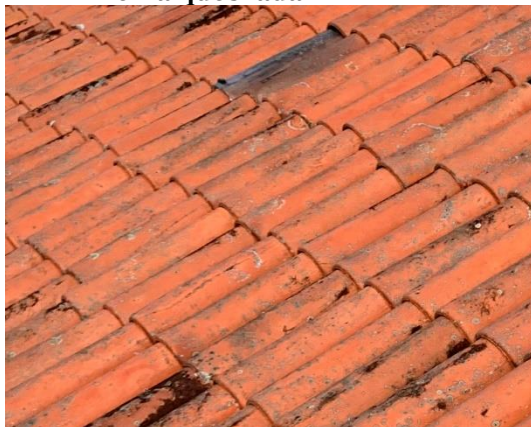
Figura 26 - Água 03 Telhas corridas e fiadas horizontais desalinhas
