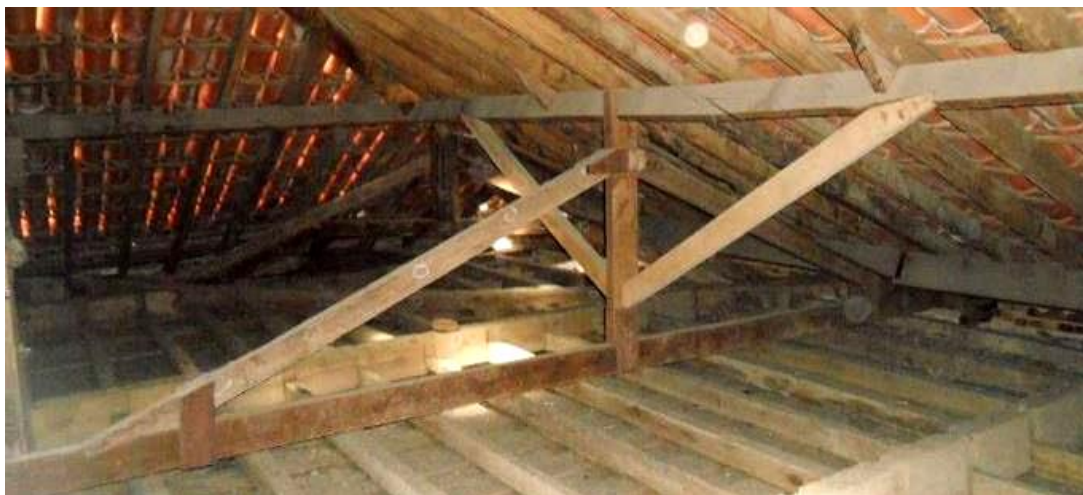
Figura 12 - Espigão entre as águas 02 e 03 e pequena tesoura para apoio da terça. Paulo Parrilha Figueiredo Filho, 2021.
