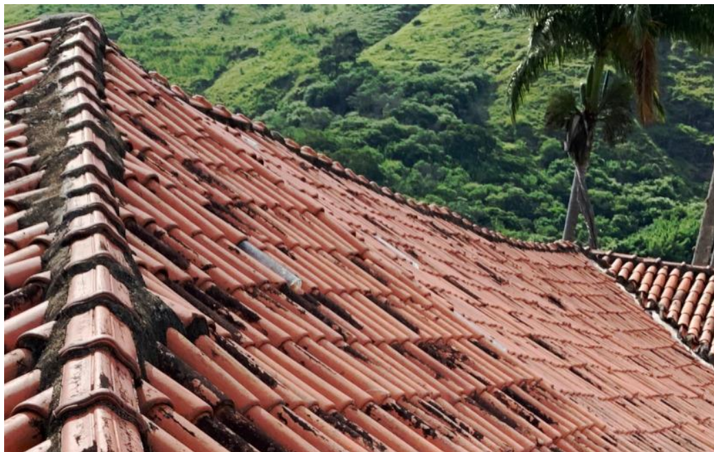
Figura 7 – Água 06 com ressaltos, cumeeira e espigão ondulados.
