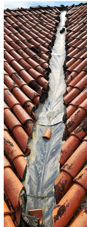
Figura 51 – Calha do espigão
