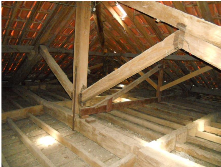
Figura 10 – Tesoura entre as água 02 e 03
