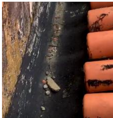
Figura 45 - Ressaltos no interior da calha. Paulo Parrilha de Figueiredo Filho, 2021.
