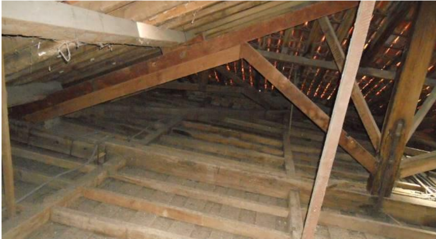
Figura 15 - Detalhe da tesoura entre as águas 03 e 05, sustentação da terça.
