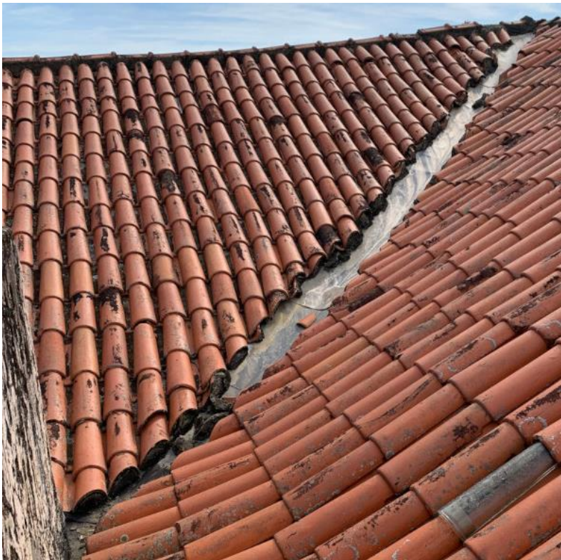
Figura 50 – Calha do espigão
