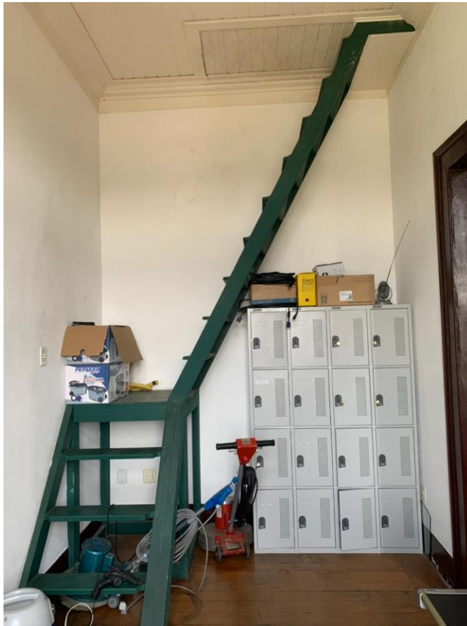
Figura 53 – Escada de acesso ao alçapão e interior da cobertura. Paulo Parrilha Figueiredo Filho, 2021.
