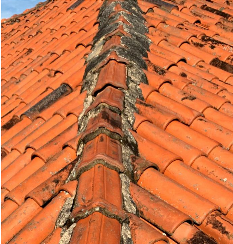
Figura 19 – Espigão entre as águas 02 e 03. Paulo Parrilha Figueiredo Filho, 2021.
