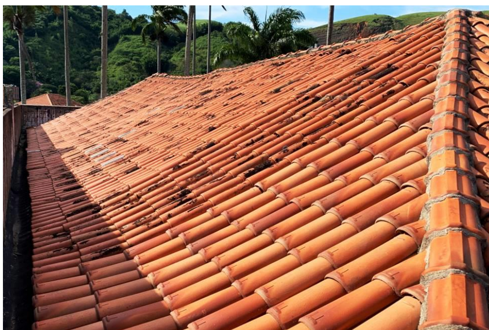
Figura 8 – Água 02 com ressaltos, cumeeira e espigão ondulados.
