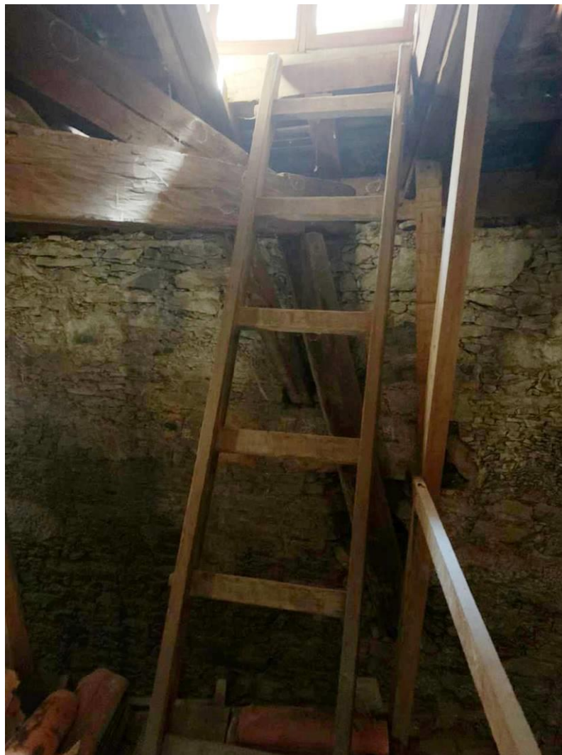
Figura 61 – Escada de acesso a área externa da cobertura via trapeira. Paulo Parrilha Figueiredo Filho, 2021
