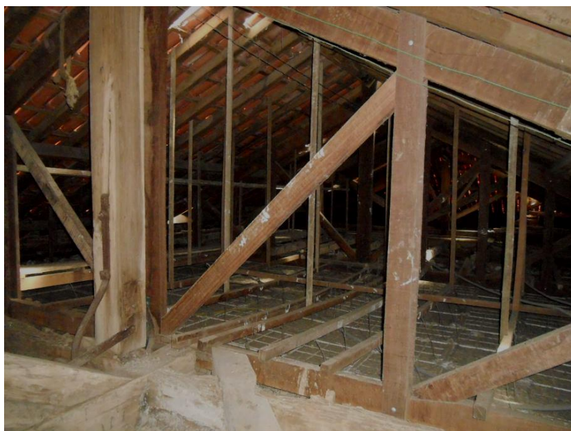
Figura 6 - Tesoura nova e pendural da antiga entre as águas 02 e 06. Paulo Parrilha Figueiredo Filho, 2021.
