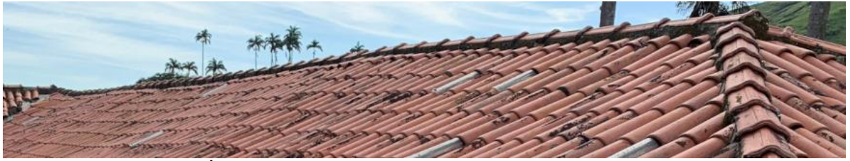
Figura 9 – Água 05 com ressaltos, cumeeira e espigão ondulados. Paulo Parrilha Figueiredo Filho, 2021.
