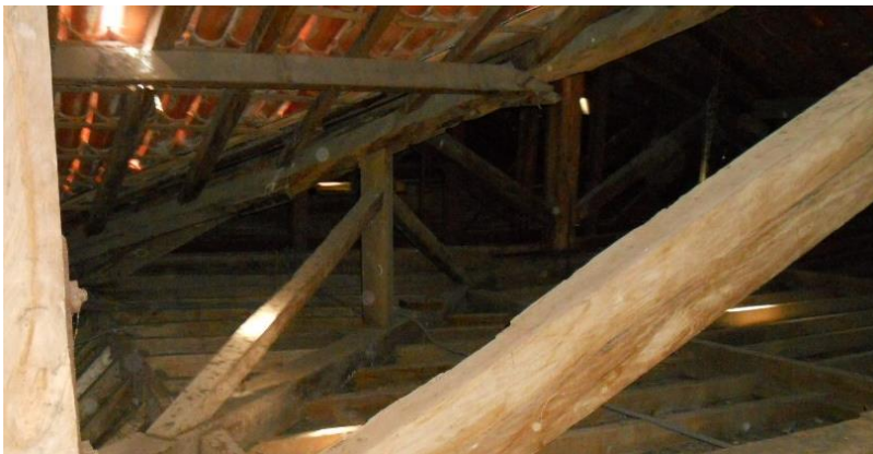
Figura 16 - Detalhe do espigão entre as 05 e 06.
