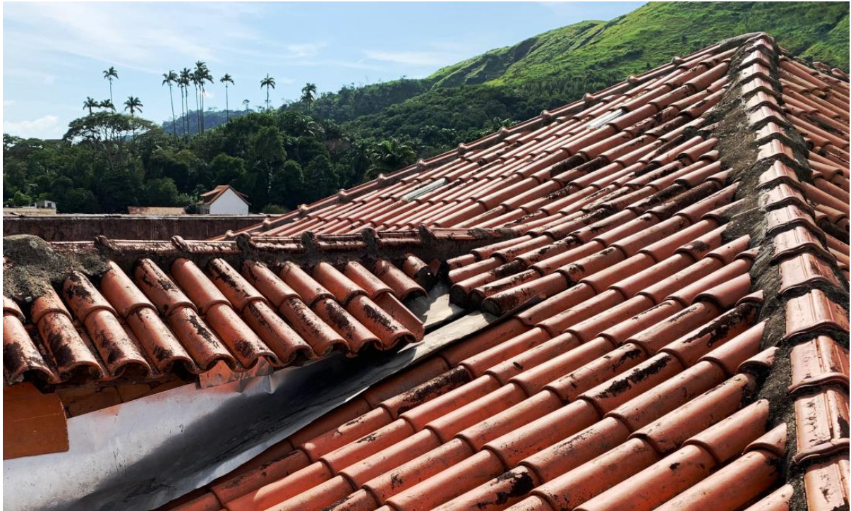
Figura 2 – Água 01 com ressalto e espigão ondulado. Paulo Parrilha Figueiredo Filho, 2021.
